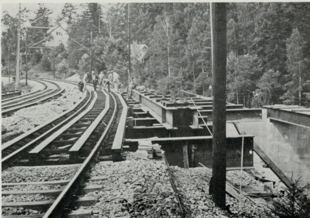
Figur 2. Skinnebru som understøtter jernbanesporene.
